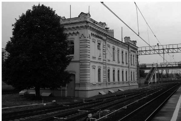
Рис. 1. Здание вокзала, подвергающееся динамическим воздействиям
